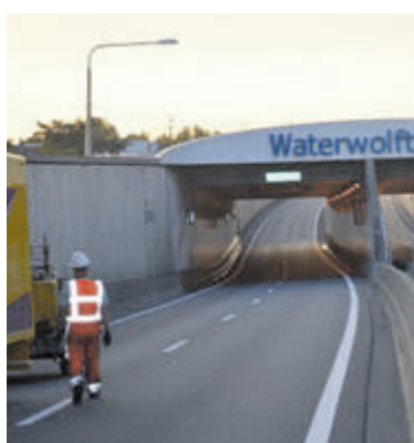
Werkzaamheden aan de Waterwolftunnel. Foto: Provincie Noord-Holland
