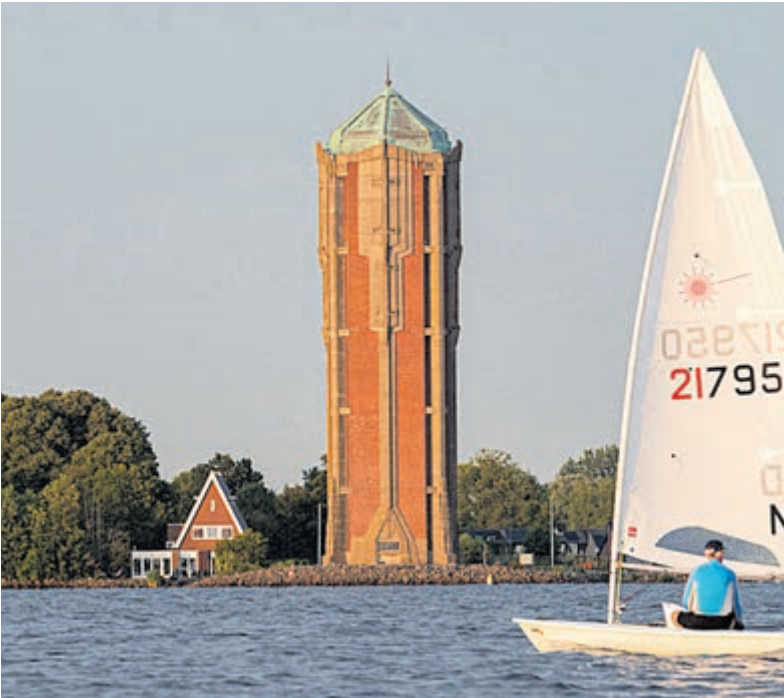
Watertoren, bakermat op het land en op het water. Foto: www.kicksfotos.nl
