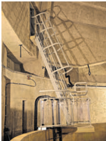
Het trappenhuis naar de top van de watertoren. Foto: aangeleverd
