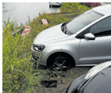
Grond weggezakt door heftige regenbui langs de dijk. Foto: Inter Visual Studio
