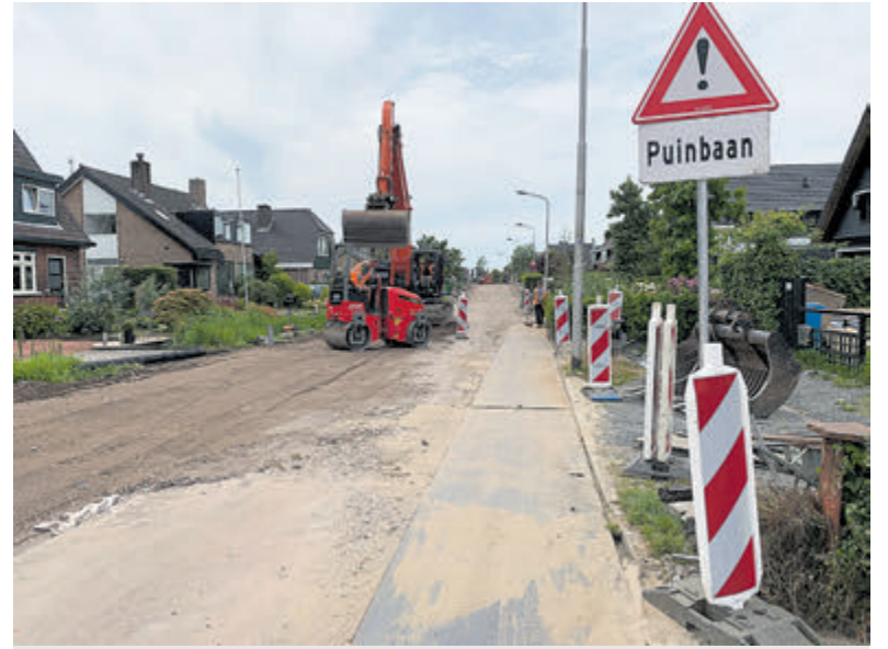
Werkzaamheden Uiterweg bij de Kees Hansenbrug. Foto: Gemeente Aalsmeer.
