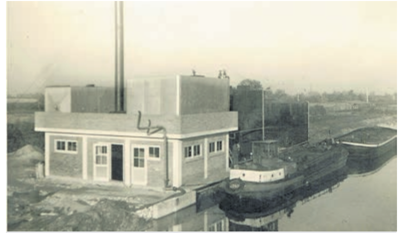
Het ketelhuis met centrifuge-installatie bij oliereinigingsbedrijf 'Het Oosten', ontwerp van architect Berghoef.
