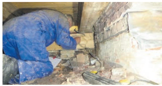
Dionijs Brugman (BORA) inspecteert de voormalige linker buitenmuur van het pand uit 1619.
