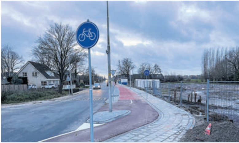
De vernieuwde Bilderdammerweg met het vrijliggende fietspad. Foto: Gemeente Aalsmeer
