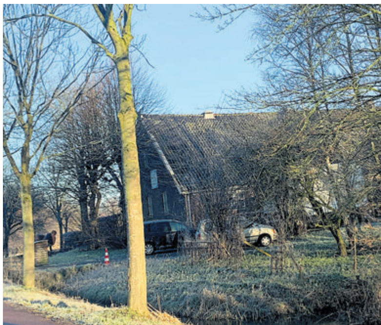
Deze boerderij aan de Abcouderstraatweg is bestempeld als 'voorkeurslocatie' voor de opvang voor dertig dak- en thuislozen. Foto: Nieuwe Meerbode.
