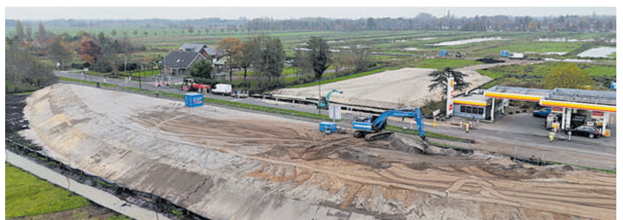
De rotonde voor de nieuwe woonwijk Maricken II in aanbouw. Foto: Gemeente De Ronde Venen.
