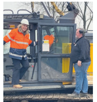
De bouw is begonnen, wethouder Anja Vijselaar heeft de eerste paal geslagen. Foto: Gemeente De Ronde Venen.
