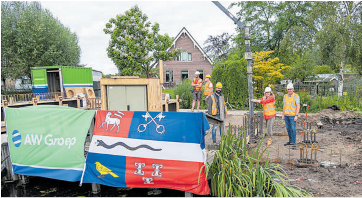
Het beton voor de fundering wordt gestort. Van links af (met baard) projectleider Nils Rasmussens van AW Onderhoud, Anja Vijselaar en gemeentelijke projectleider Peter Hogeveen. Foto gemeente De Ronde Venen
