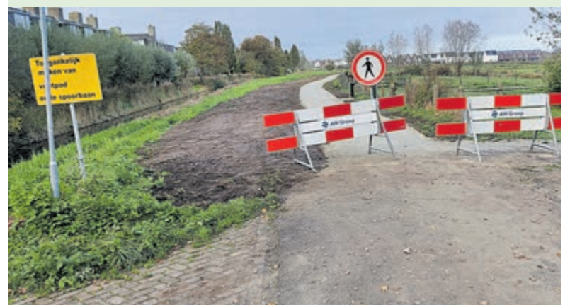
Gele borden die geplaatst waren tijdens de werkzaamheden. Foto is aangeleverd.
