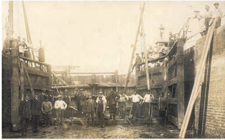
Tolhuissluis renovatie (1920). Foto is aangeleverd.
